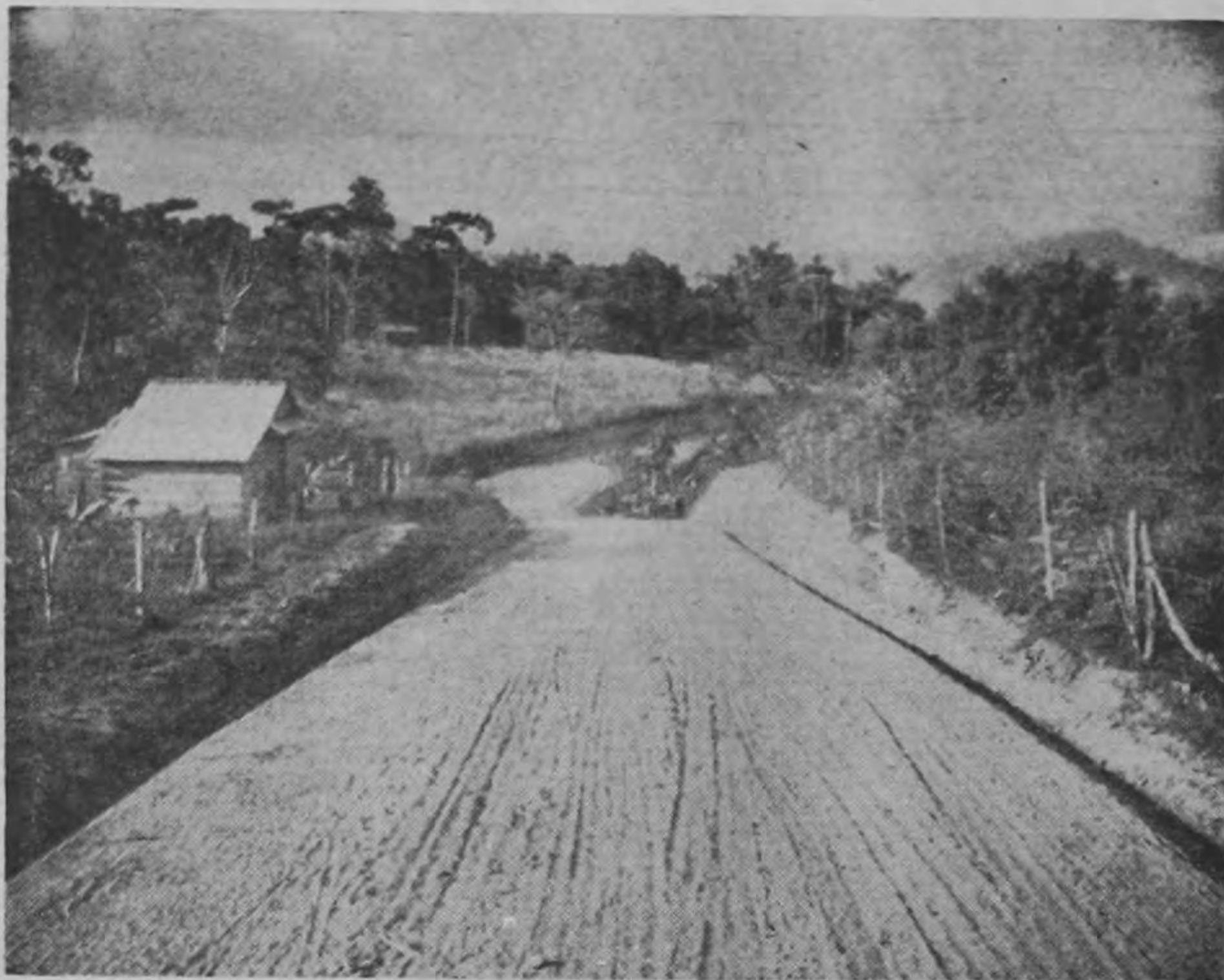
Camino a Pavones, en Pérez Zeledón, abrazando humildes casitas de campesinos costarricenses, pasa un tramo de la carretera recién rellenada por la acción progresista de Liberación Nacional.
